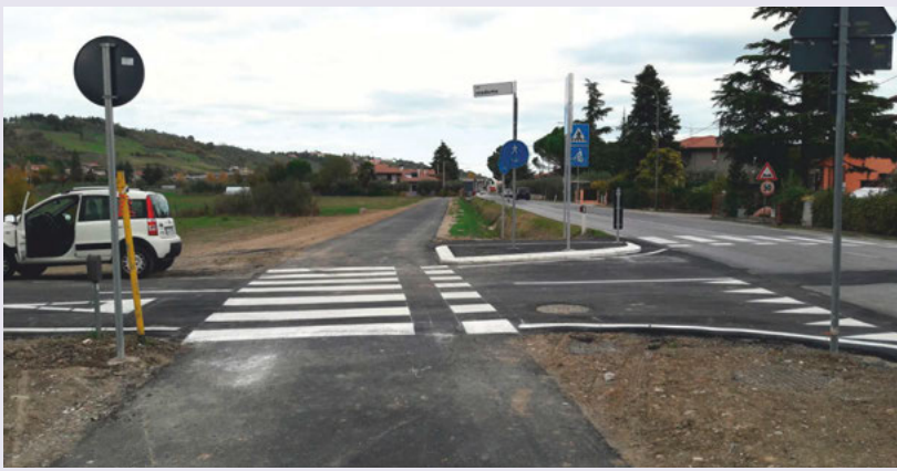
percorso ciclo-pedonale sulla SP14 a Santo Marino
