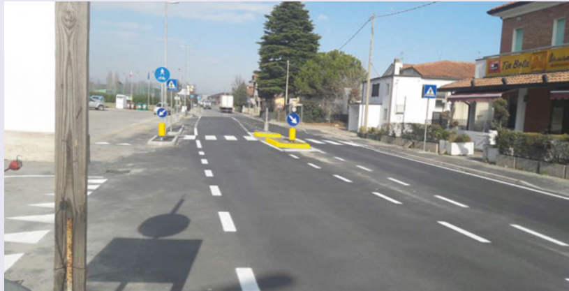
attraversamento pedonale protetto sulla SP 14 a Santo Marino
